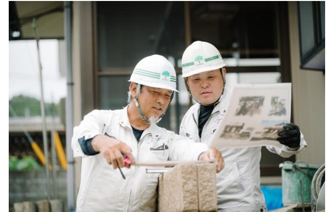
外構・土木工事
